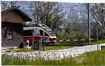
Die Schrankenanlage in Trautenfels wird automatisiert. Foto: MeinBezirk
